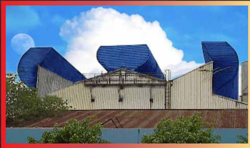
Se fabrica en lámina galvanizada o pintada en colores estándares y diferentes calibres.
